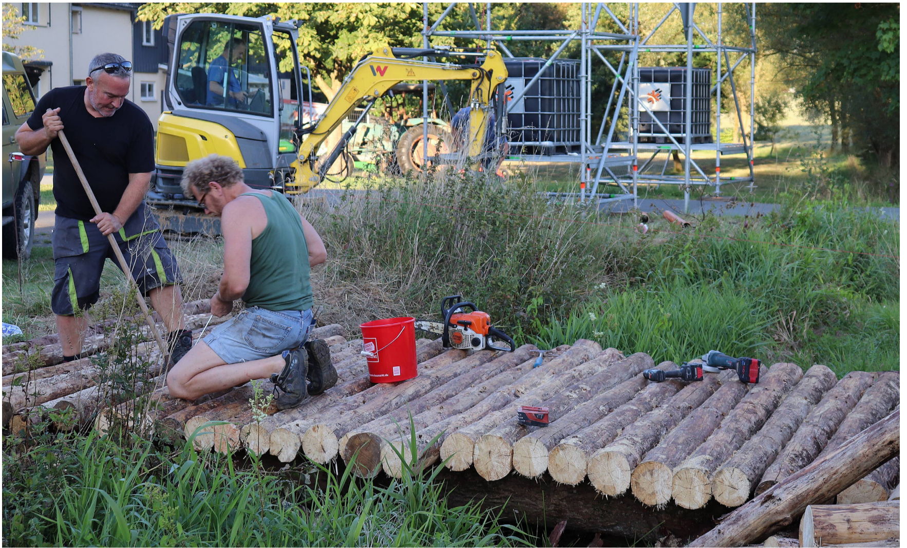
Um das Sumpfland-Festival auf das nächste Level zu heben, braucht es oft ganz banale Voraussetzungen wie den Bau einer Holzbrücke, um zu den Toilettenwagen zu gelangen, die auf die angrenzende Wiese aufgestellt werden. Fotos: Dorothee Henche
